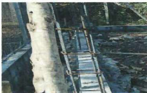
Foto 5: lado ESTE Se muestra la colocacion de columnas.
