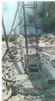
Foto 3: en esta parte se puede mostrar las columnas colocadas de la ampliacion de aula y una hilada de blok. Lado norte.
