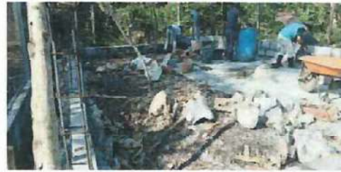
Foto 2: lado SUR La parte donde se puede mostrarse 2da hilada de blok.
